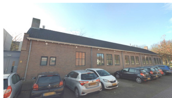
Achtergevel aan Hadewychstraat (2021 afdeling Erfgoed).
