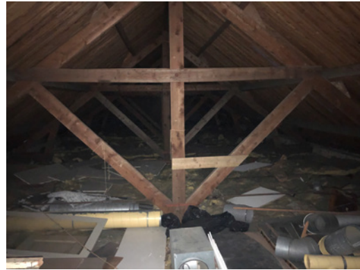
De kapconstructies van de hoofdvleugel (2021 afdeling Erfgoed).
