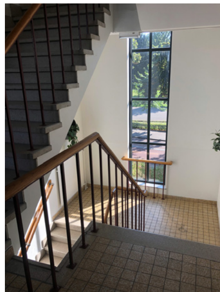
Het centrale trappenhuis (2021 afdeling Erfgoed).
