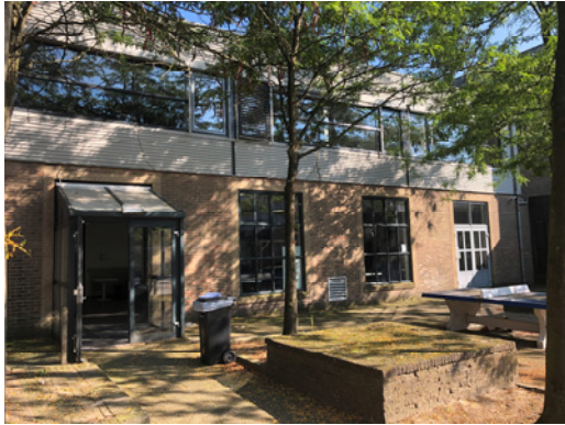
Gevel gericht naar de speelplaats (2021 afdeling Erfgoed).
