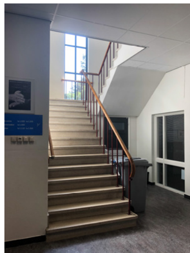
Het centrale trappenhuis (2021 afdeling Erfgoed).
